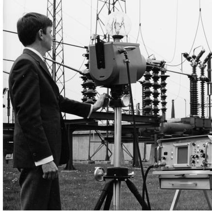
그림 14.2 1969년: Thermovision 모델 661. 카메라 무게는 약 25kg, 오실로스코프는 20kg, 삼각대는 15kg입니다. 220VAC 발전기 세트와 액체 질소가 들어있는 10L 용기도 필요합니다. 오실로스코프 왼쪽에 폴라로이드 부착물(6kg)을 볼 수 있습니다.
